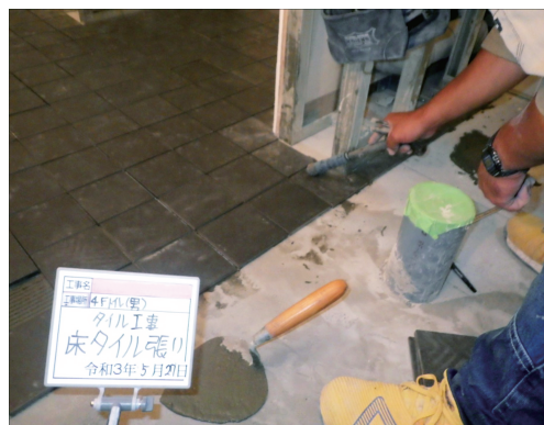
4階トイレ（男子）床タイル張り
