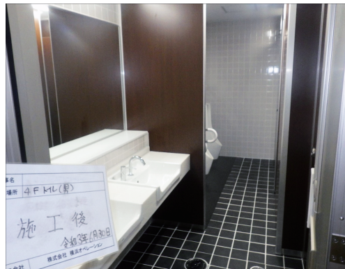
4階トイレ（男子）施工後
