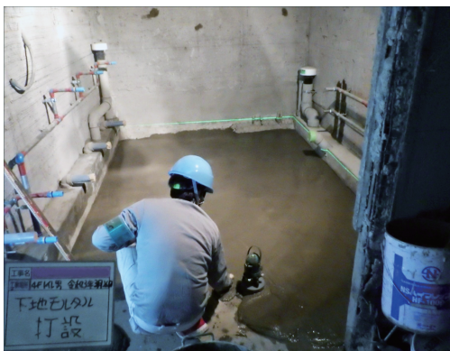
4階トイレ（男子）床下地モルタル
