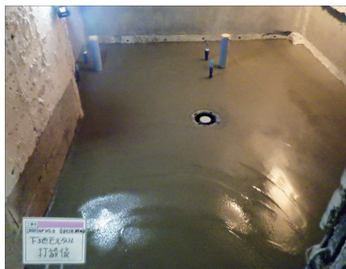
4階トイレ（女子）床下地モルタル
