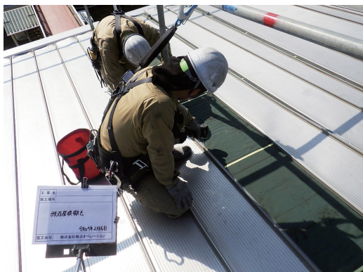
既存屋根撤去
