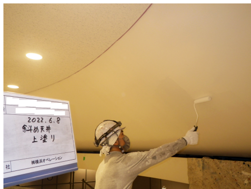
塗装工事天井塗装
