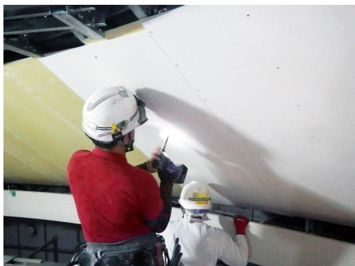
天井ボード張り
